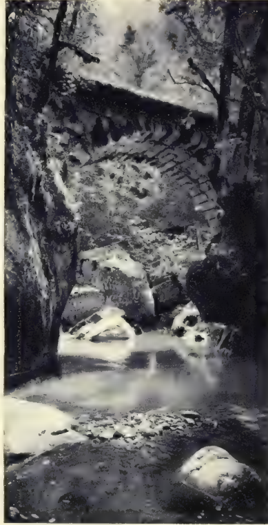
Sous le Pont de Valombré.
